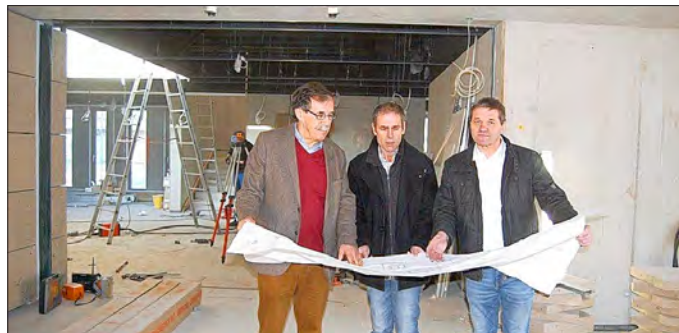
Bürgermeister Klaus Bell studiert mit dem Leiter des Fachbereiches Tiefbau, Berthold Junglas, und dem Bauleiter Reinhold Euskirchen (v. l.) den Bauplan. Fotos: Michael Harbeke
