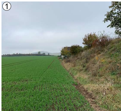
Außengebietsentwässerung oberhalb Laacher See Str.
